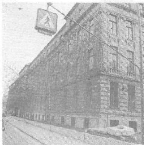
tehnično šolo ob Aškerčevi. Leta 1948 je bilo zadnjikrat obnovljeno pročelje, poleg tega pa je bila zgradba povišana za eno nadstropje.
