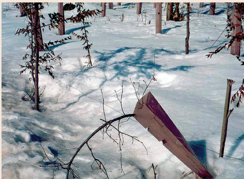
Slika 7: Primer slabo postavljenega tulca – neustrezen količek. Postavitev ni zdržala obremenitev, ki jih prinaša zima.
