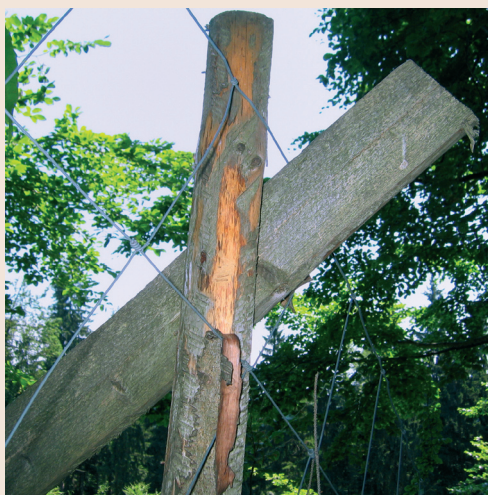
Slika 23: Konstrukcija in vpetje škarjastega nosilca na vrhu
