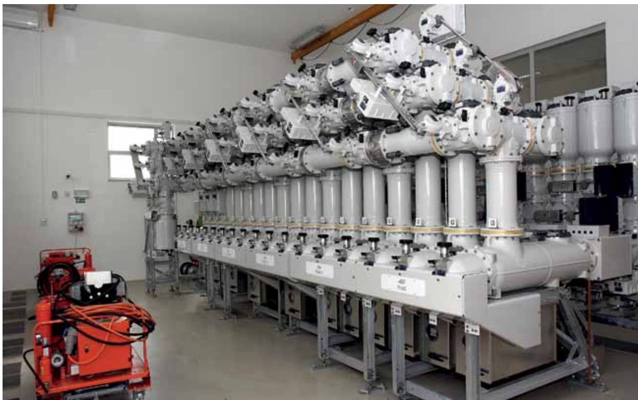
Oktobra je potekala montaža ključne opreme GIS.
