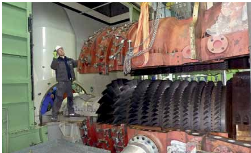
Nameščanje zgornjega dela ohišja turbine.
