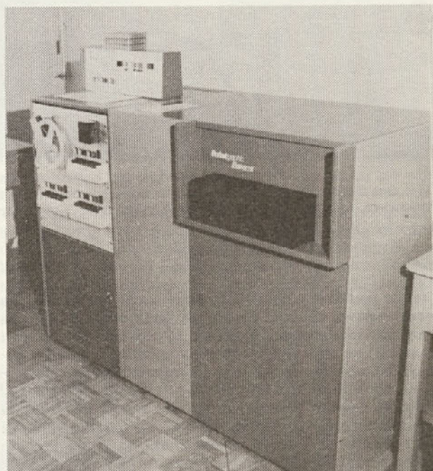
KOMPJUTRSKA in OSVETLJEVALNA enota v fotostavnem sistemu. S to napravo upravlja fotostavec-operator
