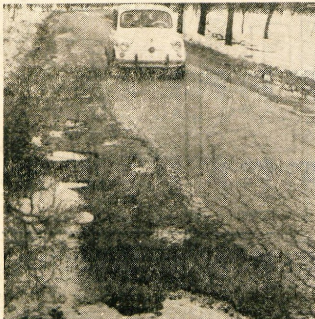
Ceprav smo tako rekoč še sredi zime, se na gorenjskih cestah že kaže škoda. Posebno na tistih, kjer je asfaltna prevleka tanjša, kaže, da bo škoda precej velika — Foto F. Perdan
