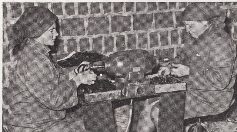
Dodelava (brušenje) stiskanih izdelkov
