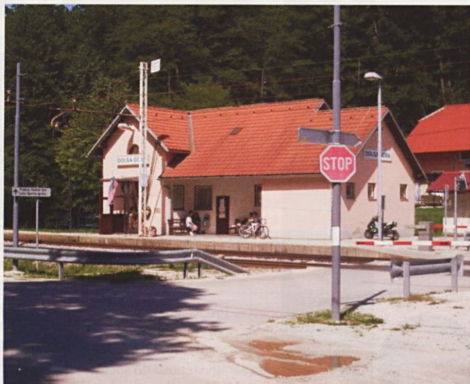
V sklopu obnovitvenih del na železnici bodo obnovili tudi postajališče Dolga Gora.
