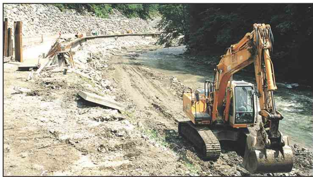
Najtežja dela na zahtevnem cestnem odseku so izvajalci že opravili.
