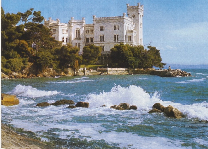
Miramarski grad nad Grljanskim zalivom, zgrajen leta 1860 na odkupljenih vinogradih slovenskih vaščanov. Obdaja ga park.
