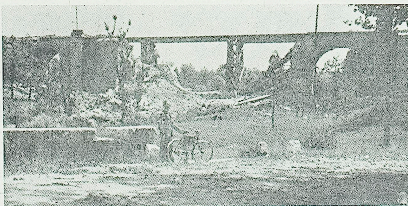
Železniški most v Prestranku, kakršnega so dobile naše enote maja 1945. Bil je večkrat bombardiran in temeljito porušen od zavezniških letal. Za silo obnovljen je bil nato nadomeščen z novim leta 1946. Na sliki: porušeni most, kakršen je bil še junija 1945
