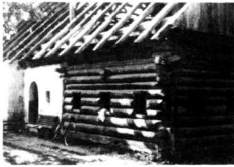
Hafnerjeva rojstna hiša – Martančev dom v Binklju 4, poleti 1969 med podiranjem. (Foto Franc Pokorn, iz arhiva Franca Hafnerja)
