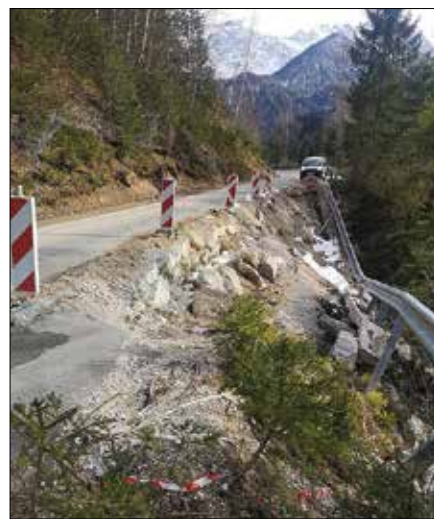
Podjetje VOC Celje bo na odseku ceste do Pavličevega sedla saniralo posledice plazov. (Fotodokumentacija Občine Solčava)
