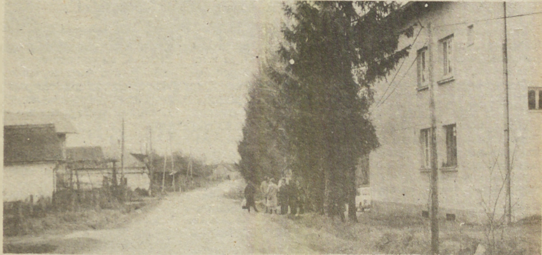
Čez nekaj mesecev se bo prosenjakovska pošta preselila v zadružni dom (desno na posnetku), kjer je tudi že samopostrežna trgovina. Pravkar urejajo prostore za poslovanje s strankami in za namestitve večje telefonske centrale, ki bo omogočila razširitev telefonije v KS Prosenjakovci, Selo-Fokovci in Ratkovci. (Foto: J. G.)
