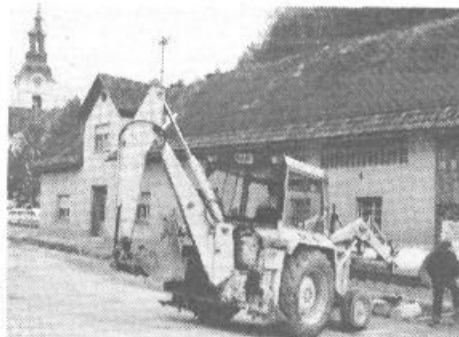
Nadaljevanje gradnje kanalizacije
