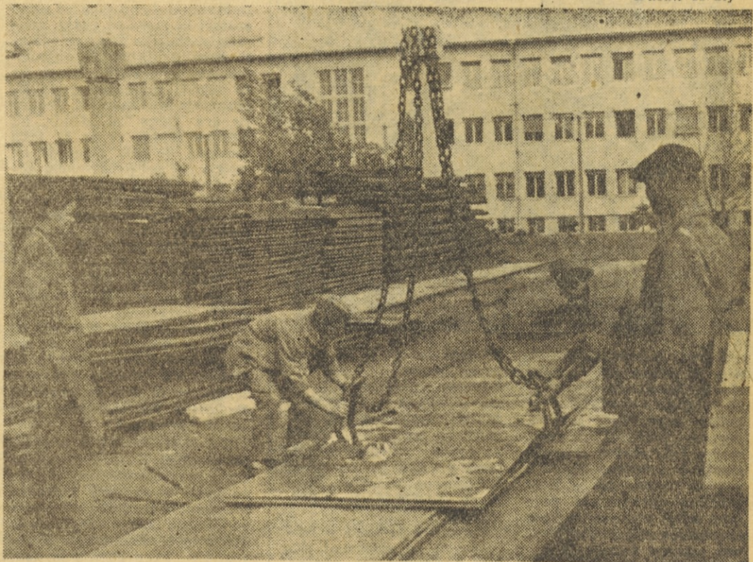
Na dvorišču »Metalne« v Mariboru: brigadirji in delavci sestavljajo prve dele mostovne konstrukcije
