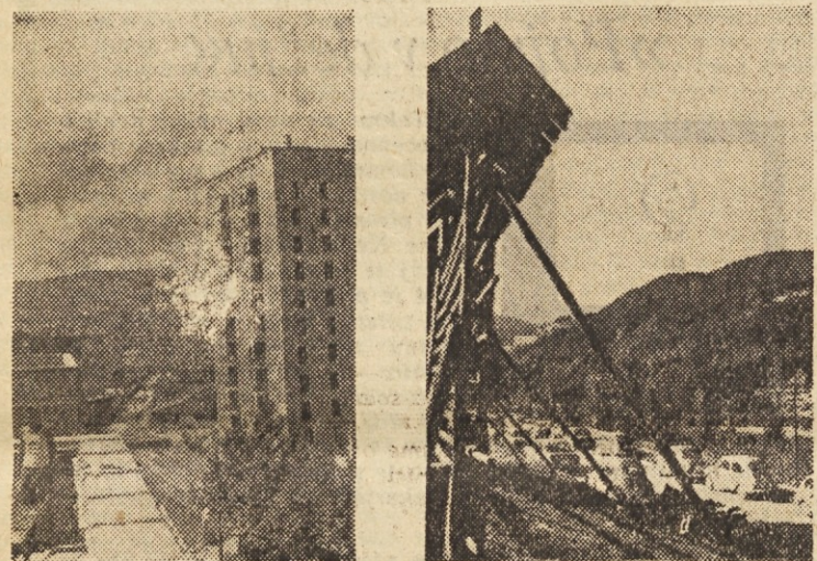
Levo: Nova koprška stolpnica, ki je kamen spotike mnogih Koprčanov, ki že dalj časa čakajo na stanovanje, pa tudi drugih. Že lep čas dograjena stolpnica na Vojkovem nabrežju je namreč še vedno neveljena. Nekateri pravijo, da sta projektant in investitor »pozabila« na kanalizacijo. Prizadeti pa bi očitno radi čimprej popravili slab vtis in prav v teh dneh mrzlično polagajo cementne cevi, ki bodo postale sestavni del sicer že skrajno neustreznega in nezdruživega kanalizacijskega omrežja v Kopru. Desno: Kolona ob žičnici v Kranjski gori.
