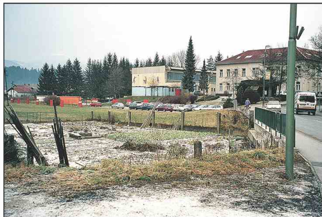
Tu bo stala nova šoštanjska osnovna šola. Gradnja se je začela z rušenjem starega.
