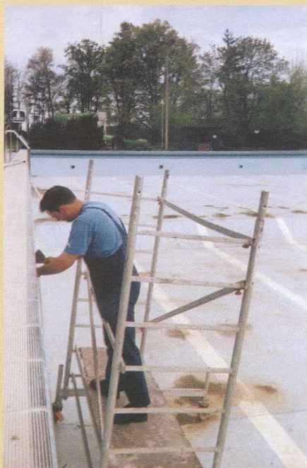
Odstranjevanje vodnega kamna s keramičnih ploščic olimpijskega bazena
