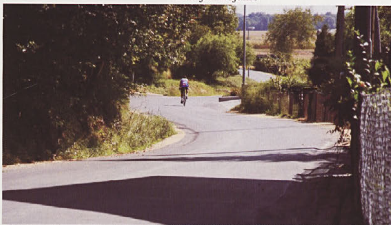
V Zamušanih je končana izgradnja primarnega kanalizacijskega omrežja in preplastitev ceste
