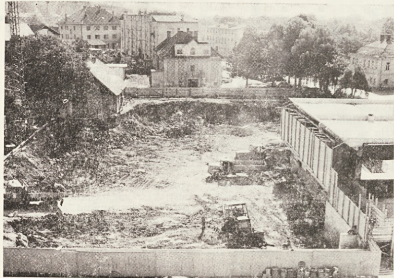
Pogled na gradbišče nove blagovne hiše v Cerknici. Ugodno vreme omogoča hitro gradnjo
