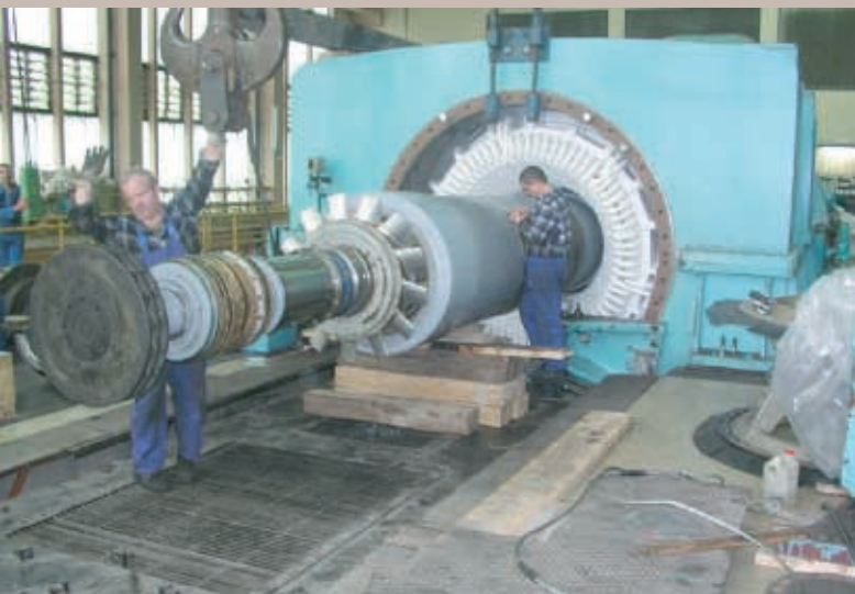
Nameščanje obnovljenega rotorja generatorja
