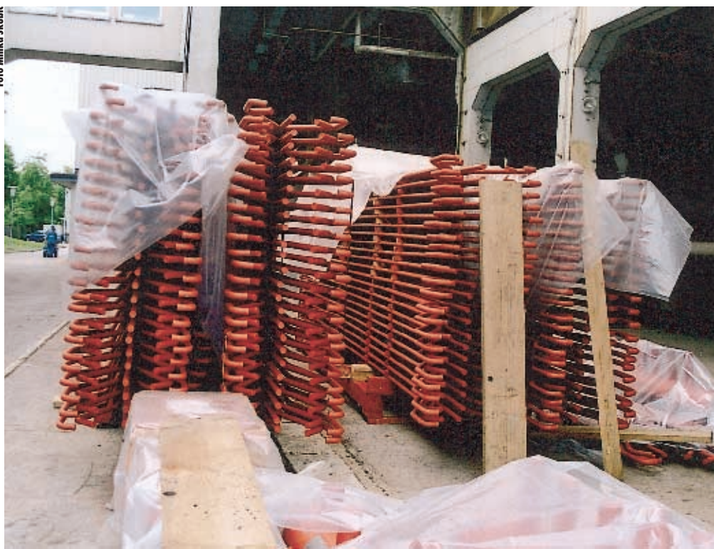
Končni pregrevalniki čakajo za montažo v kotel II. bloka.
