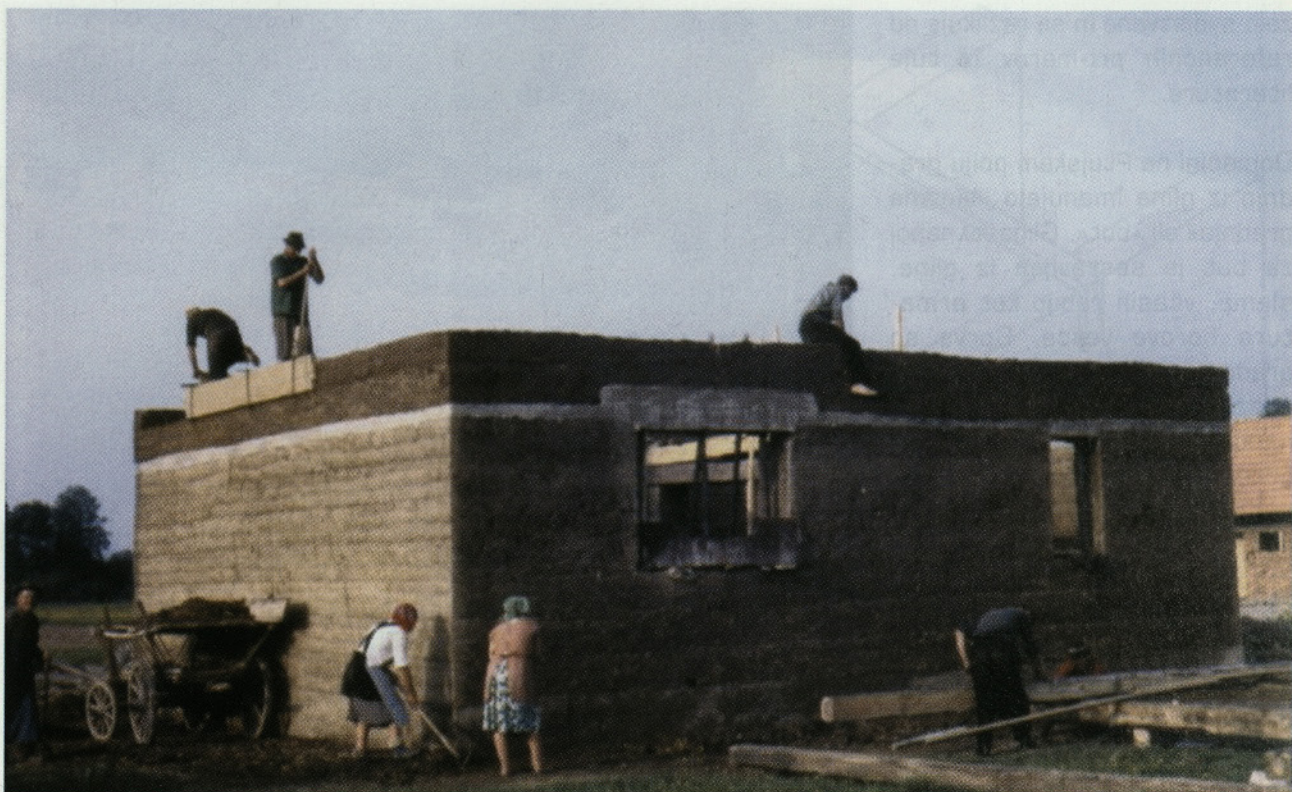
Slika 6. Gradnja butane hiše na Ptujem polju (foto: Dušan Maškon)
