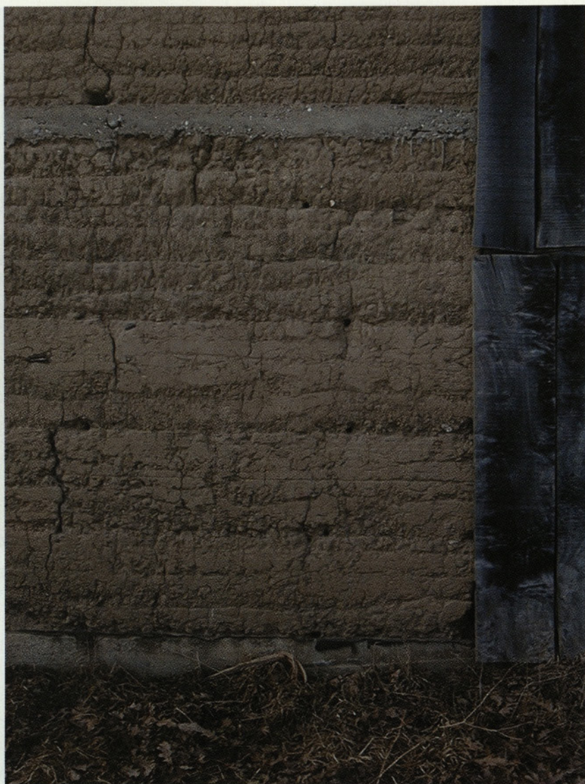
Slika 5. Butan zid iz gline, na katerem je vidna betonska vez ter posamezne vrste buta in luknje kovinskih spon, ki se po končanem butanju izvlečejo (foto: M.Z.S.)
