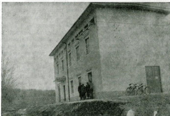
Transformatorska postaja Grosuplje
