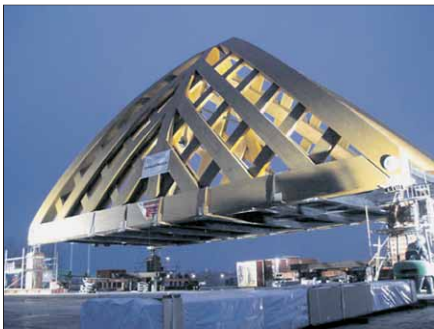
Pri natančni postavitvi 60 ton težkega lesenega mostu na svoje mesto je bil uporabljen Enerpacov digitalni sinhroni dvizni sistem
