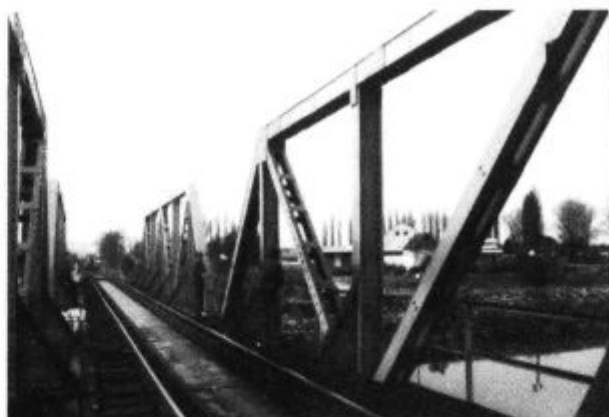
Slika 4: Kovičen železniški most čez Dravo na Ptuj
