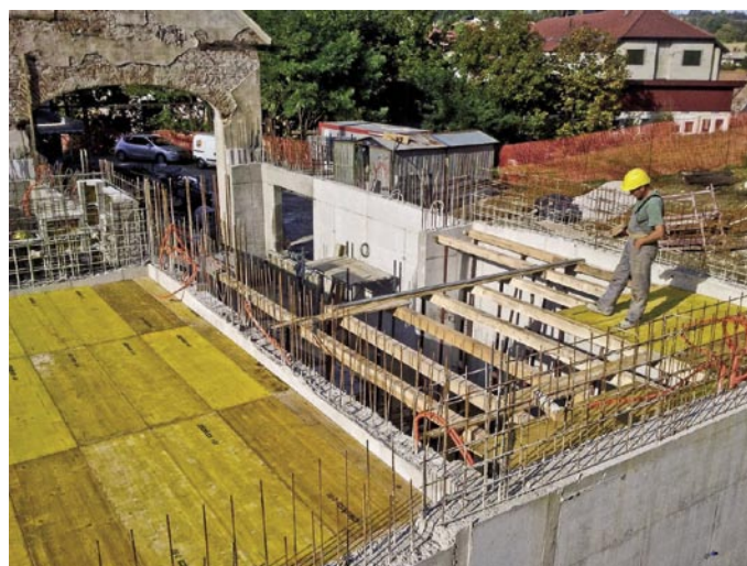
Slika 4 • Opaževanje stropne plošče nad pritličjem prizidka
