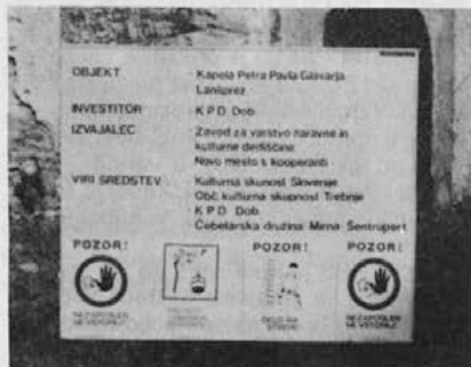
Tudi tabla pred gradbiščem z opozorili naznanja pričetek del.
