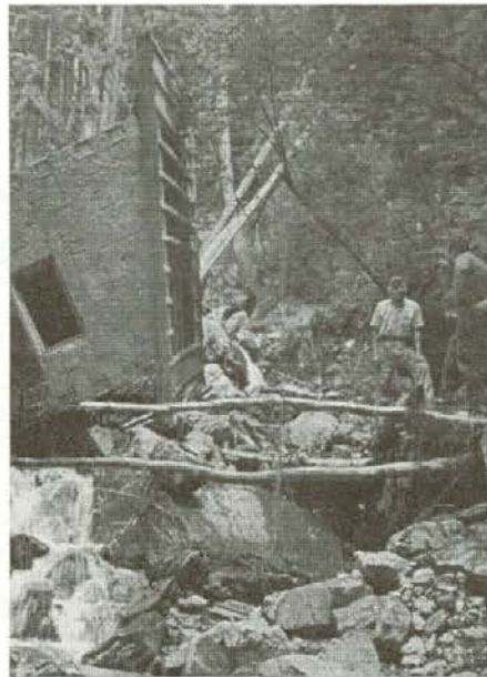
Kmetu Feliksu Knezu, po domače Spodnjemu Kotniku v Razborju je voda prevrnila hidroelektrarno
