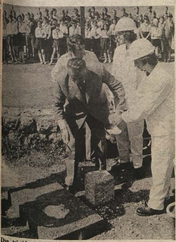
Dve, tri zidarske žlice betona in temeljni kamen za novi dom JLA v Novem mestu se je pod roko generalpolkovnika Staneta Potočarja - Lazarja, načelnika generalštaba JLA, „prijel“. (Foto: I. Zoran)
