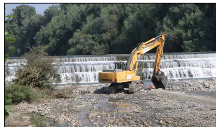
Sanacijska dela na Podvinskem jezdu
