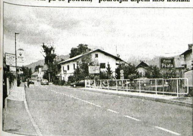
Na Gorenjski cesti je bil obnovljen most s priključki na kanalizacijo in drugo komunalno infrastrukturo.
