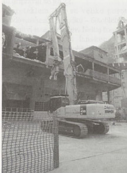
Rušenje stare zgradbe priprave premoga, ki je odslužila, s specialnim 'rušilcem'
