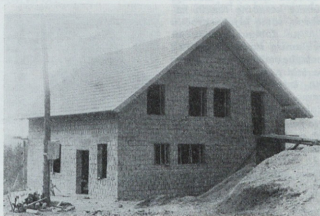
Lovski dom LD Mislinja v gradnji
