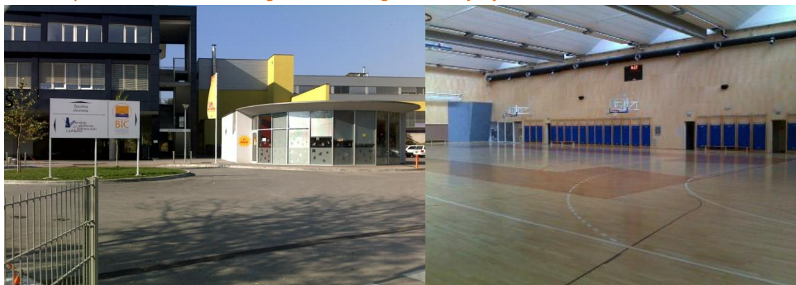
Slika 32. Športna dvorana Biotehniškega izobraževalnega centra v Ljubljani
