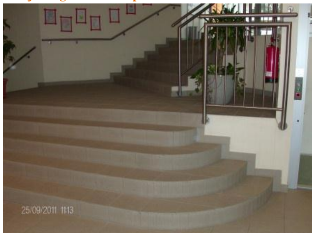
Prikaz 27: Stopnišče, ki je oviralo dostop do športne dvorane gibalno oviranemu učencu, in dvigalo, ki mu sedaj omogoča ta dostop
