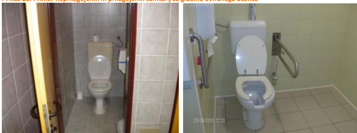
Prikaz 20: Primer neprilagojenih in prilagojenih sanitarij za gibalno oviranega učenca
