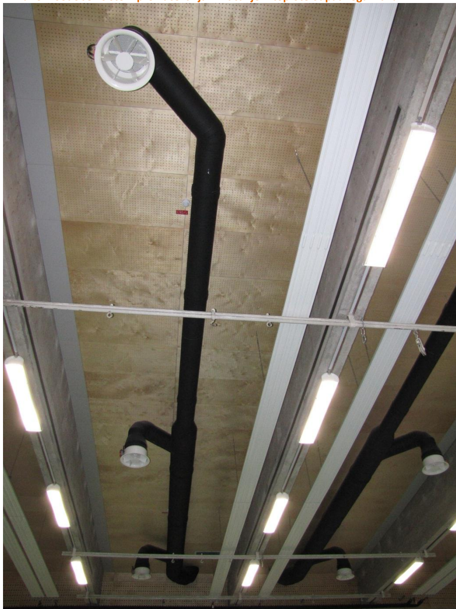
Prikaz 51: Sodoben sistem prezračevanja z vračanjem toplote odpadnega zraka
