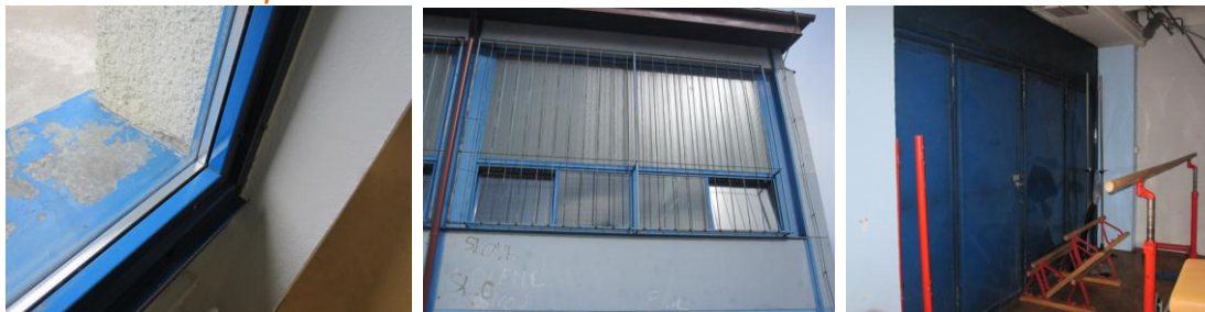
Slika 31: Okna in vrata športne dvorane
