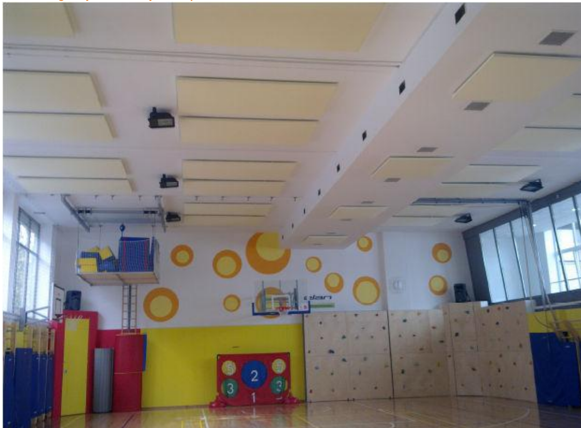
Prikaz 61: Vgradnja akustičnih jader v športni dvorani Škrlatica
