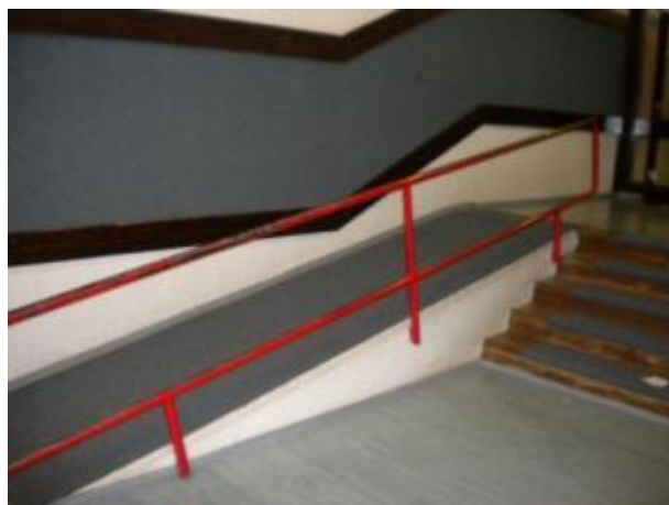
Prikaz 16: Primer neustreznega premagovanja višinske razlike pri vstopu v športno dvorano za gibalno oviranega učenca in primer ustrezne rešitve
