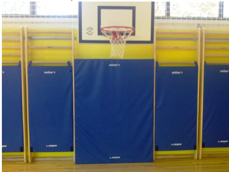
Slika. Primer zaščite letvenikov z blazinami in zaščite naletna površine za malim košem z debelo blazino (istočasno skladišče za to blazino)
