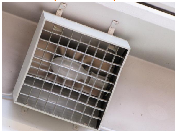
Slika 27: Zaščita sijake: varnostna ohišja svetilk in nosilci zanje
