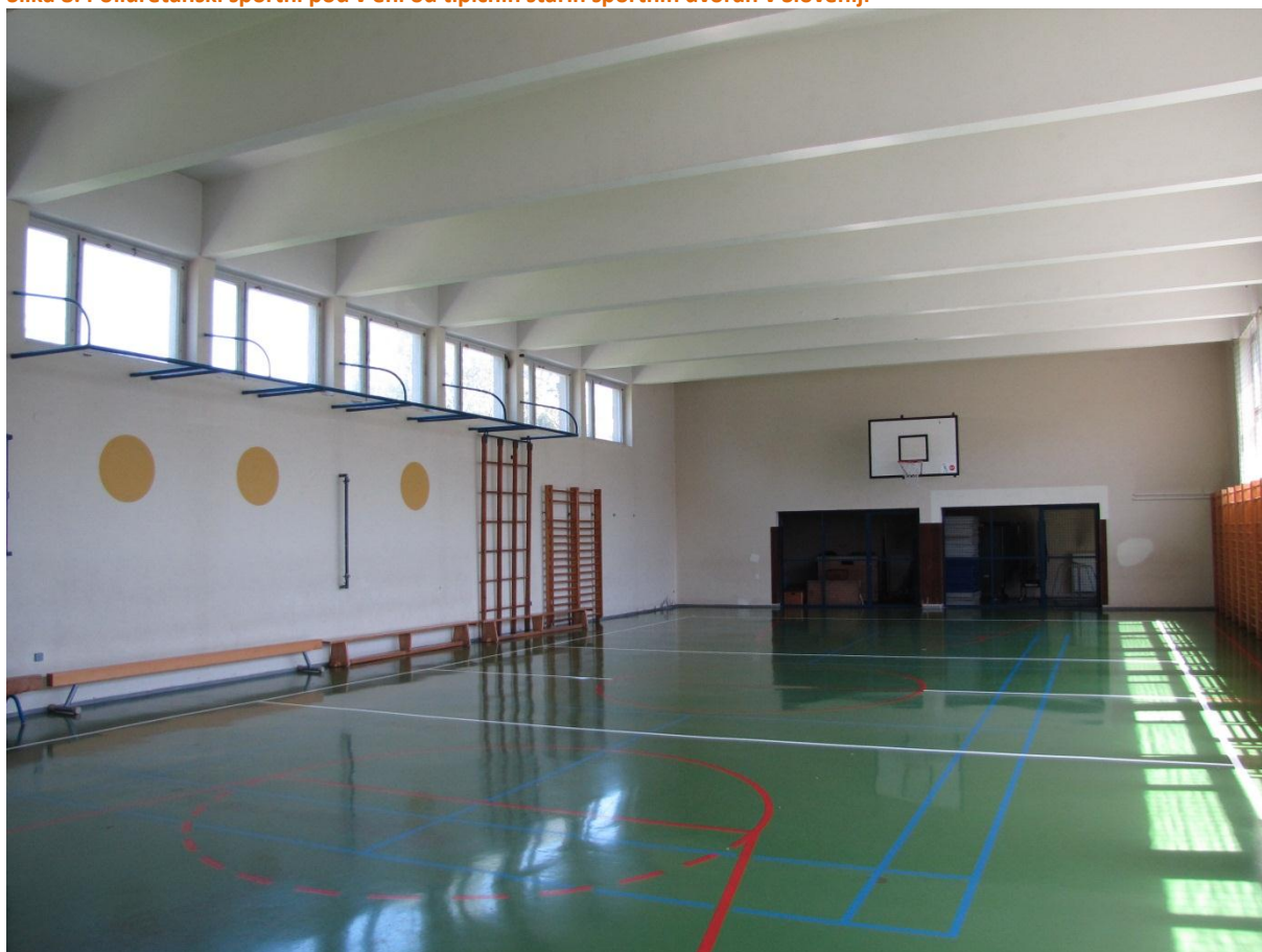
Slika 8: Poliuretanski športni pod v eni od tipičnih starih športnih dvoran v Sloveniji
