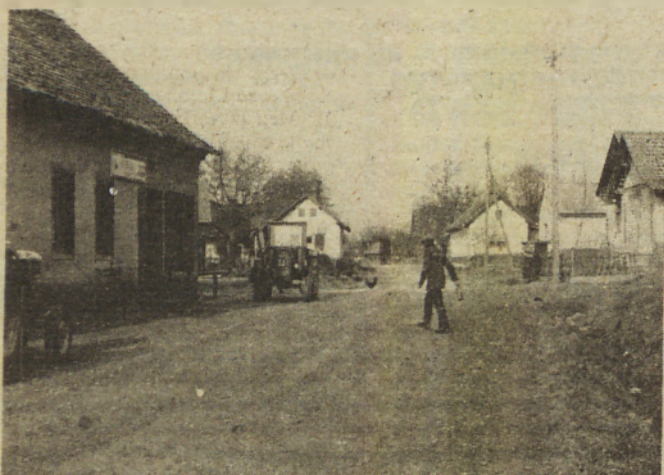
Zgradba (na levi strani), v kateri sta zdaj trgovina in (nekakšna) dvorana za kulturne prireditve, je dokaj v slabem stanju. Motvarjevčani si želijo nekaj novega.
