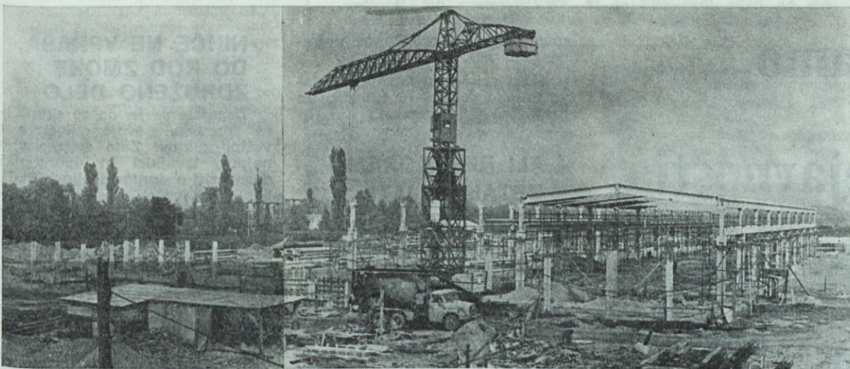
Gradbišče nove hale TVN, ki nezadržno raste (Foto: Žlebnik)
