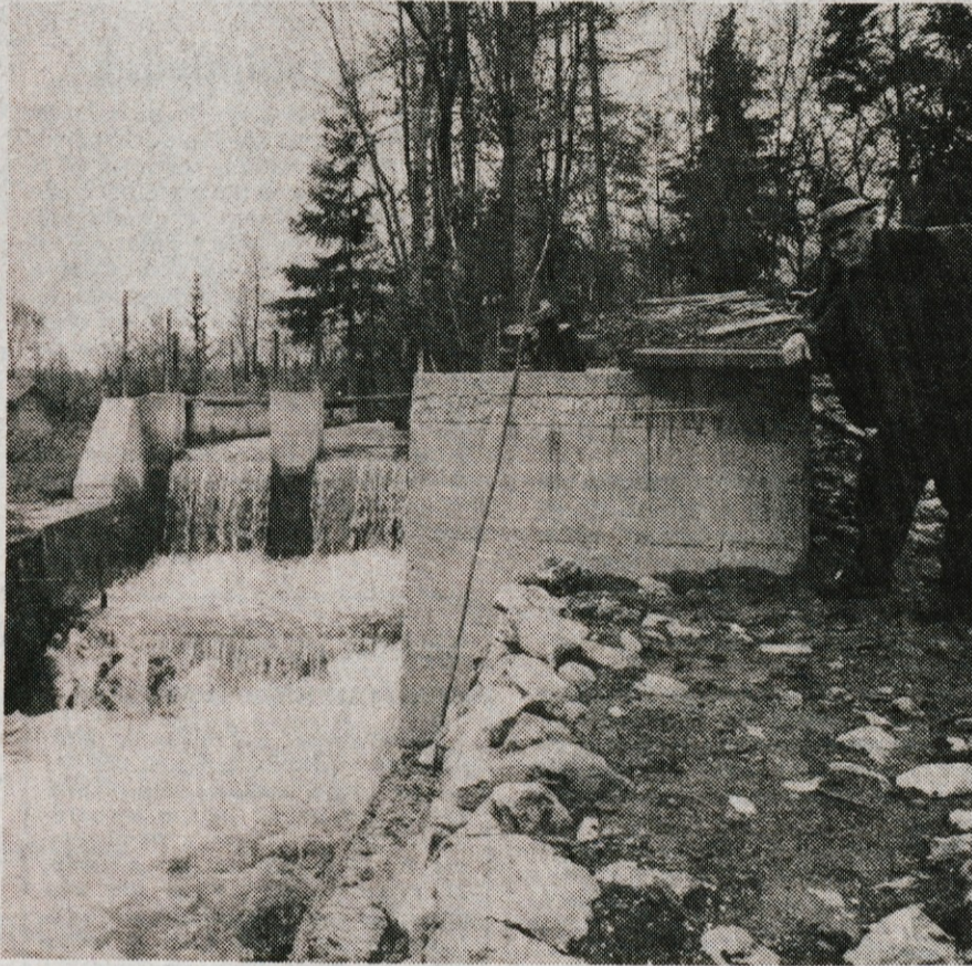
Sr. Bela — Pri Kračmanu, ob rojstni hiši Matije Valjavca, so Belo zajeli in del vode speljali po ceveh do nekaj deset metrov postavljene male elektrarne z močjo do 15 kilovatov. — Foto: L. M.
