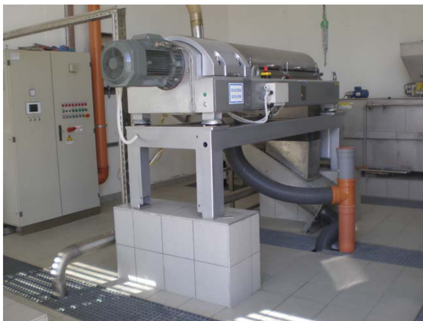
Slika 7: Naprava za dehidracijo tekočega blata – kontinuirna aksialna centrifuga (CČN Radovljica, 11.2.2009)
