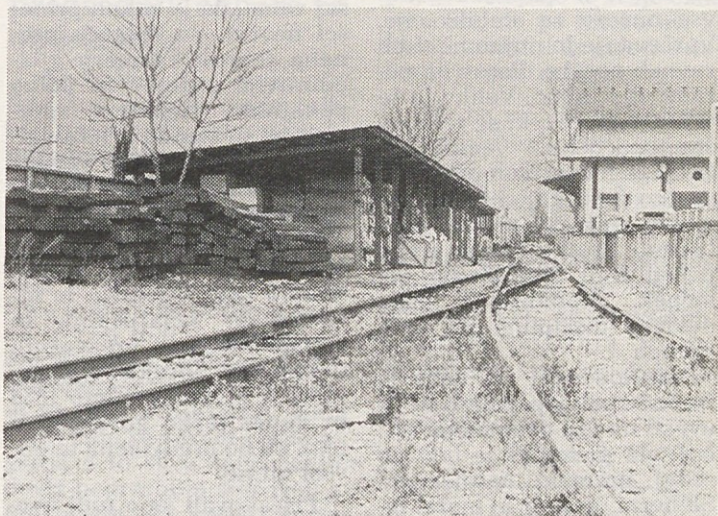
Nabavili smo nove, hrastove železniške prage (na sliki levo), za popravilo našega industrijskega tira, pri katerem so ti že močno nagniti. Prage bodo zamenjavali delavci vzdrževalne skupine Nadzorništva proge Litija. Delo bo potekalo postopoma, in bo končano v dveh letih.
