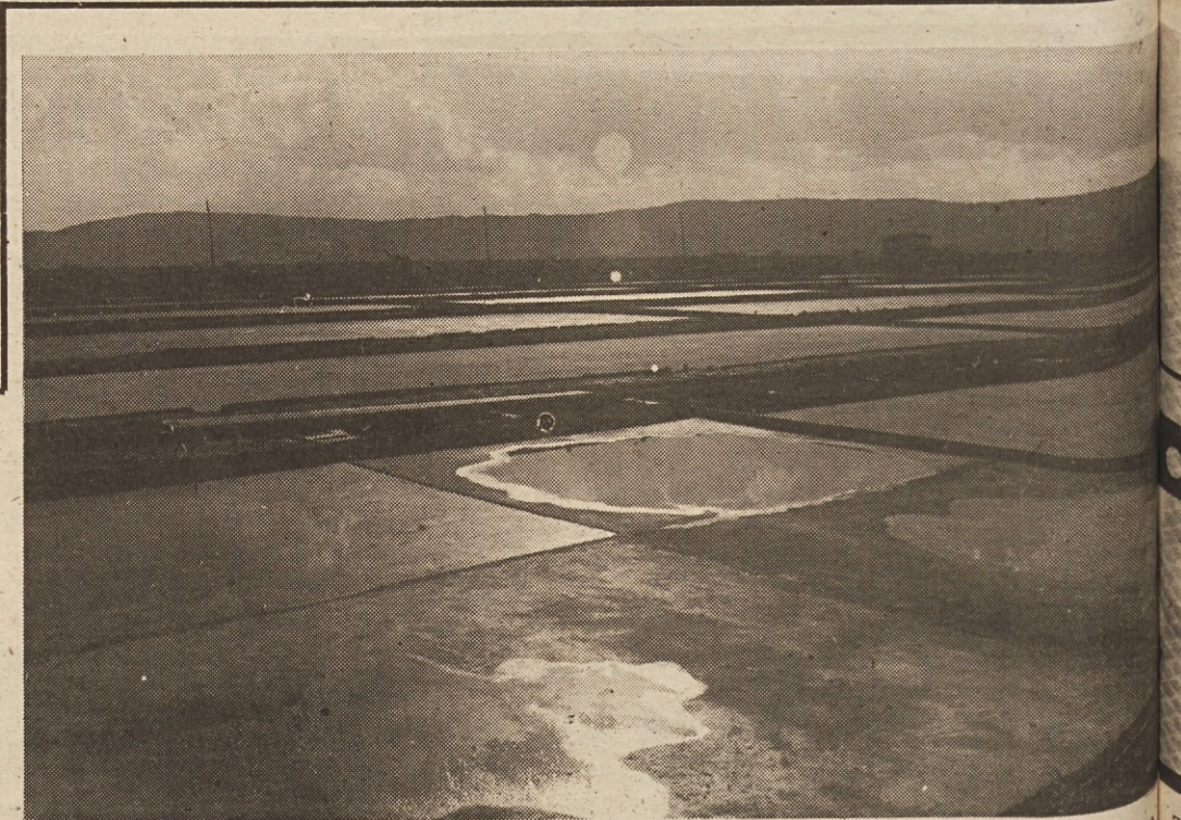
Nekaj poskusno betoniranih bazenov. Kakšna usoda čaka ostale ...? (Foto: A. Ulaga)
