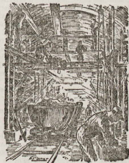
Gradnja moskovske podzemne železnice
