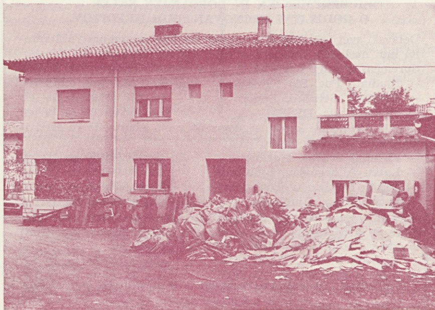
Upravna zgradba poslovalnice v Novi Gorici
