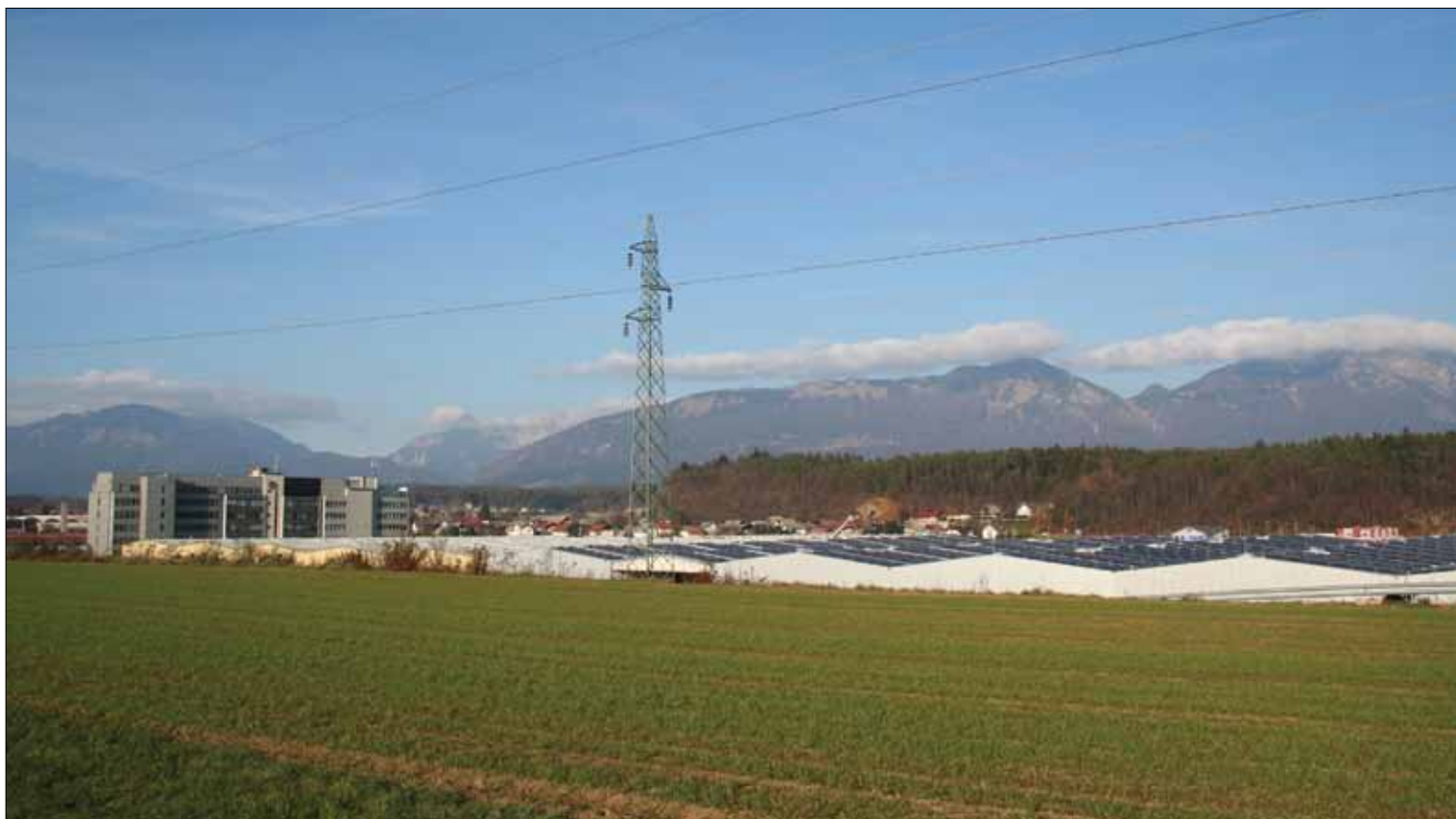
Sončna elektrarna, nameščena na strehah Merkurjevih skladišč
