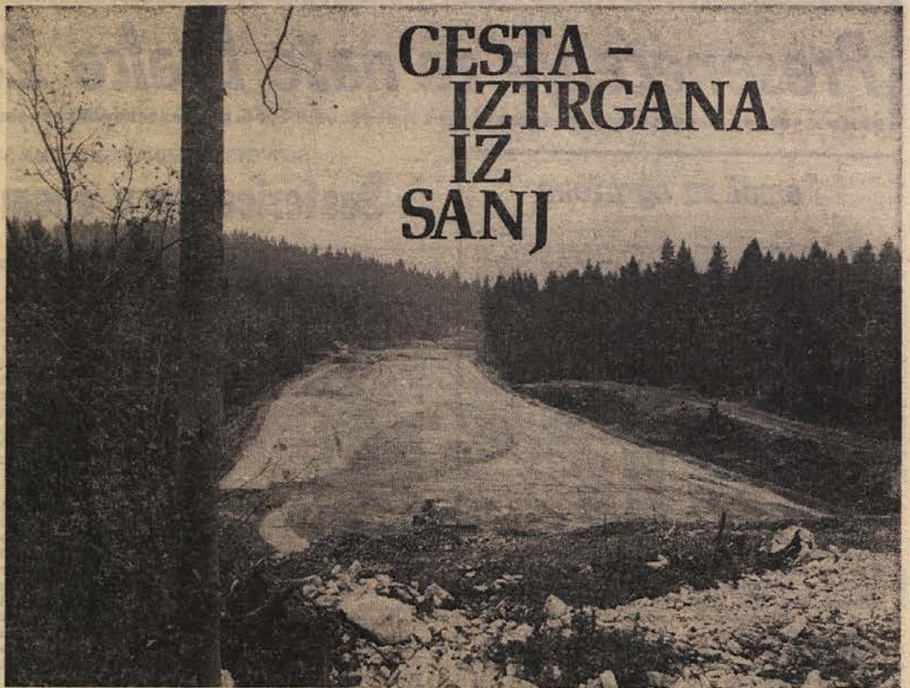
Takale je danes trasa bodoče štiripasovne ceste. Posnetek je narejen pri Štampetovem mostu.
