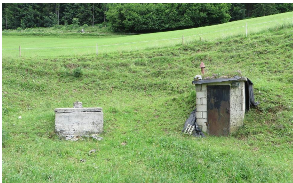
Slika 11: Primer vodnega zajetja dolvodno od bivalnega objekta (Avtorica: Nina Krašovec).
