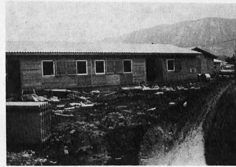
V Nemah postavljajo jugoslovanski tehniki prefabricirane hiše tipa «Jelovica». Čeprav jim nadleguje slabo vreme, gre delo kar lepo od rok
