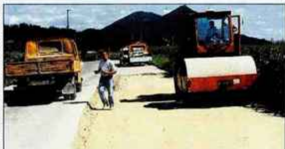
Po podpisu pogodbe so delavci začeli z deli.
