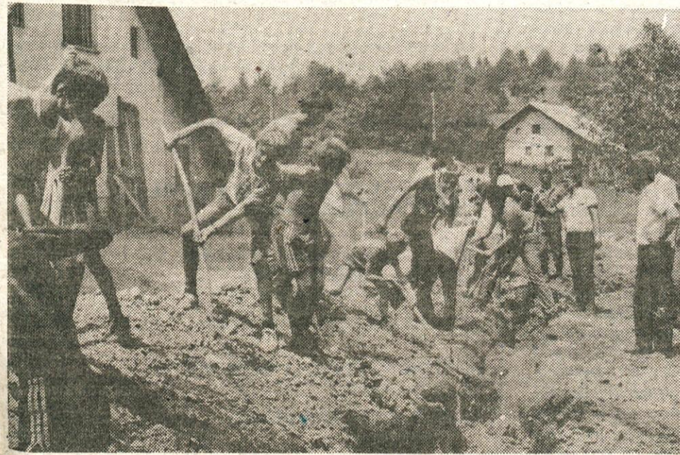
Veliko dela na trasi novega vodovoda so opravili vojaki iz enote Rifata Šehoviča. Njim pa so se nekajkrat pridružili tudi mladinci.
