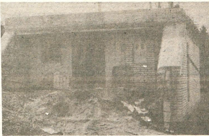
Eden od treh rezervoarjev, eden je na Padežu, dva pa na Zavrhu, od koder potem voda gravitacijsko pada.
