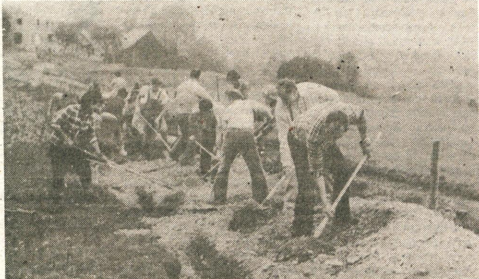
Šest sobotnih dopoldnevov so priskočili na pomoč pri zasipanju cevovoda tudi delavci in občani prostovoljci.
