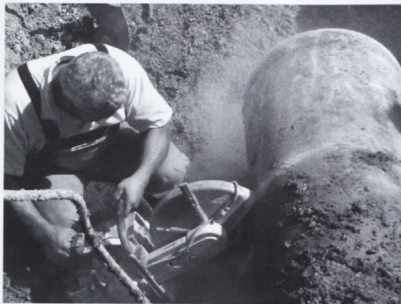
Na fotografiji: Popravilo okvare na magistralnem vodovodu Otočec–Novo mesto (lokacija Mačkovec), 28. maja 2003. Delavec na sliki reže azbest-cementno cev DN 500 mm in pripravlja spoj z novo duktilno cevjo enakega profila. Viden je oblak azbestnih vlaken, ki pri tem nastaja, zato ima monter tudi zaščitno masko.
