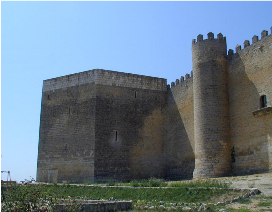
Slika 39: Palača Montealegre v Valladolidu, Španija: primer masivne gradnje (Rudofsky, 1964, 124).
