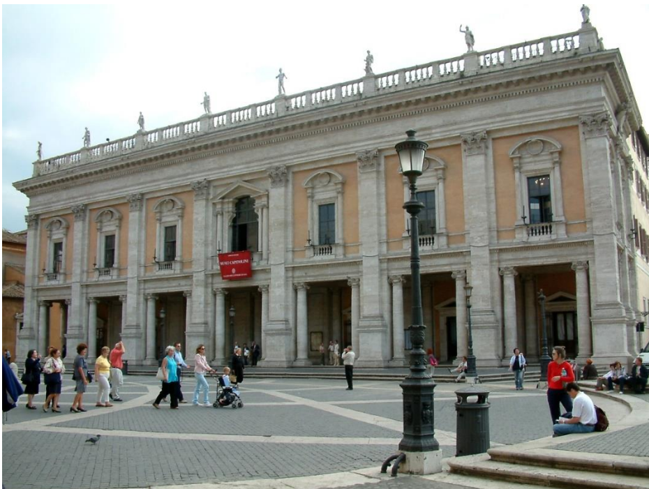
Slika 40: Michelagelov Kapitolio: artikulacija masivnega zidu s visokimi, večnadstropnimi pilastrami (Summerson, 1991, 73).
