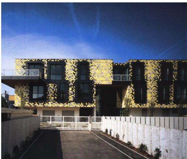
Slika 65: Razkranjanje površine z barvo, J. Sadar, B. Vuga, kondominij Trnovo v Ljubljani (arhiv avtorice).
